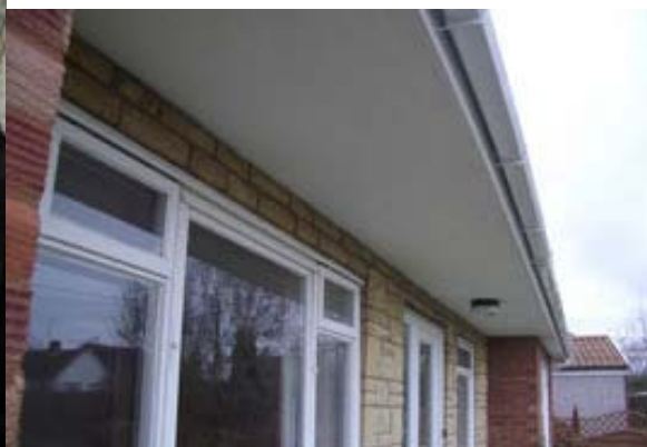
AIB External Soffit
